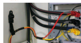
クリップが電圧コードの自重で金属端子から外れやすい場合、Z5004で電圧コードを補助して設置できます。
